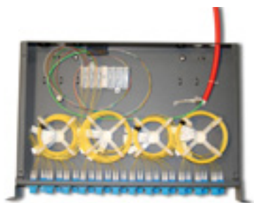
Rys. 5. Widok kabla światłowodowego z przyspawanymi pig-tailami
