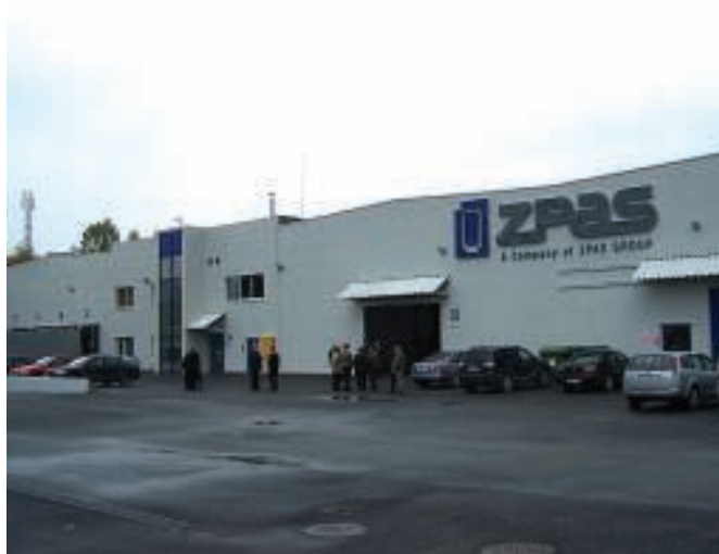
Hala produkcyjna ZPAS w Nowej Rudzie-Słupcu
