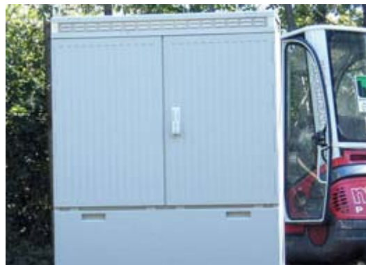
Szybka i ekonomiczna rozbudowa
